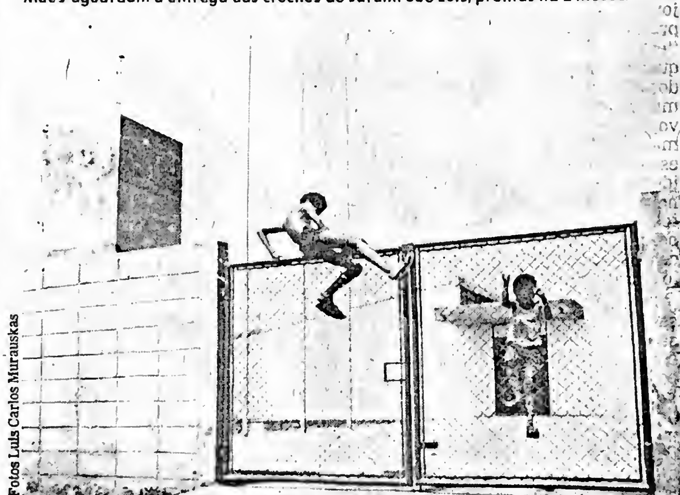
Outra unidade concluída no Jardim Ernestina permanece fechada há dois anos.
