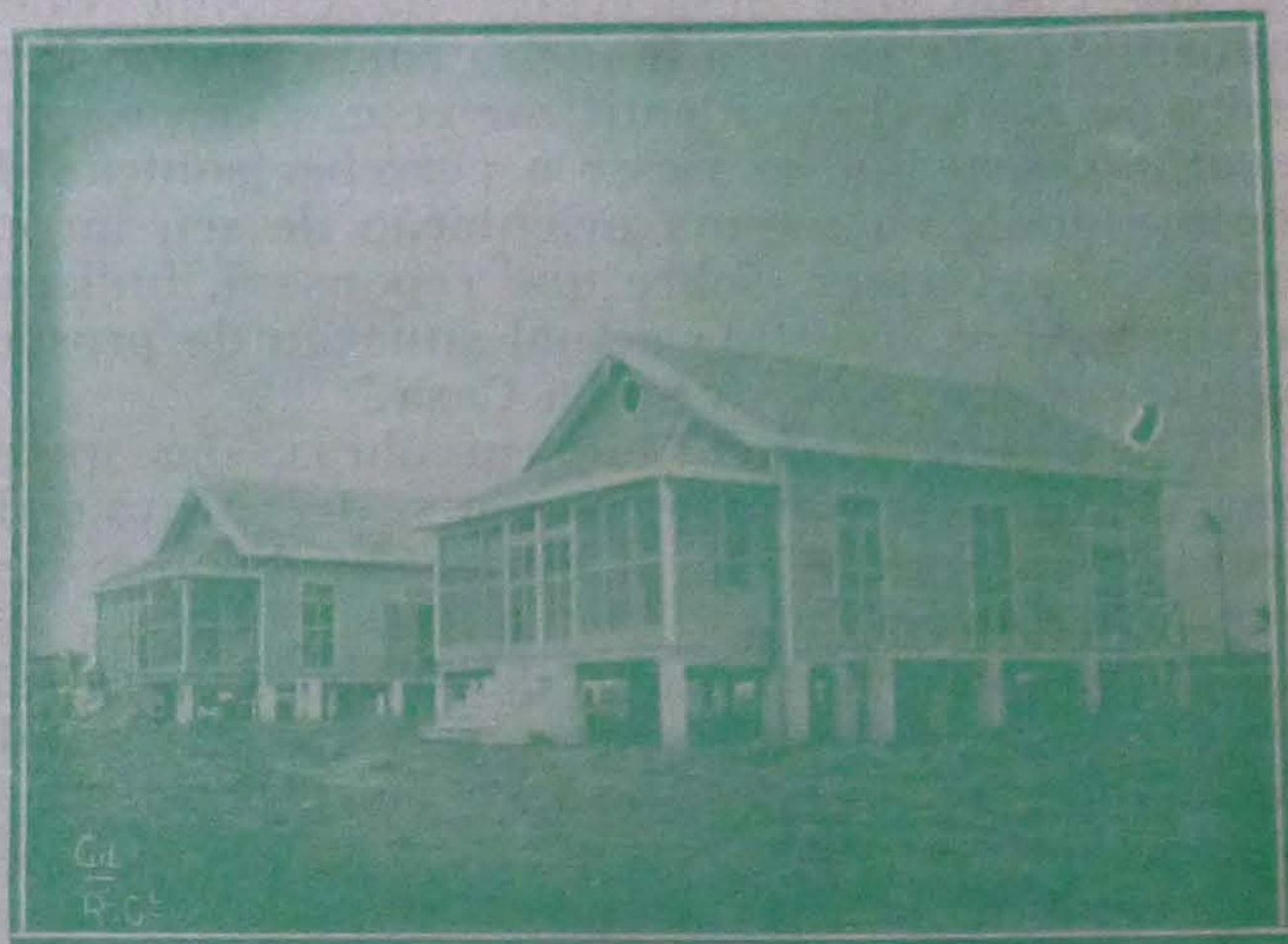
GRUPO DE CASAS DO LEPROSARIO "BELLARIO PENNA", obra do actual governo do Estado
