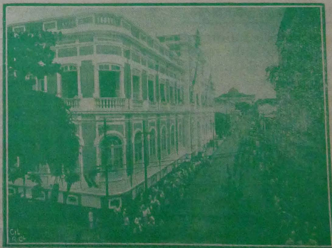
EDIFÍCIO DA ASSEMBLÉA LEGISLATIVA Vista tirada na installação dos trabalhos, a 14 de julho de 1928. No primeiro andar funciona a Bibliotheca Publica.
